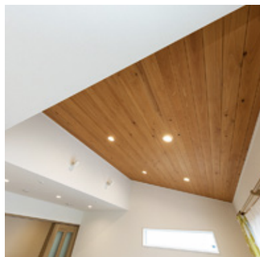
天井・壁/無垢板貼り
